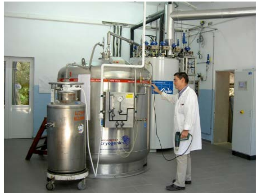
Linde L70 He liquefier (Portugal)
