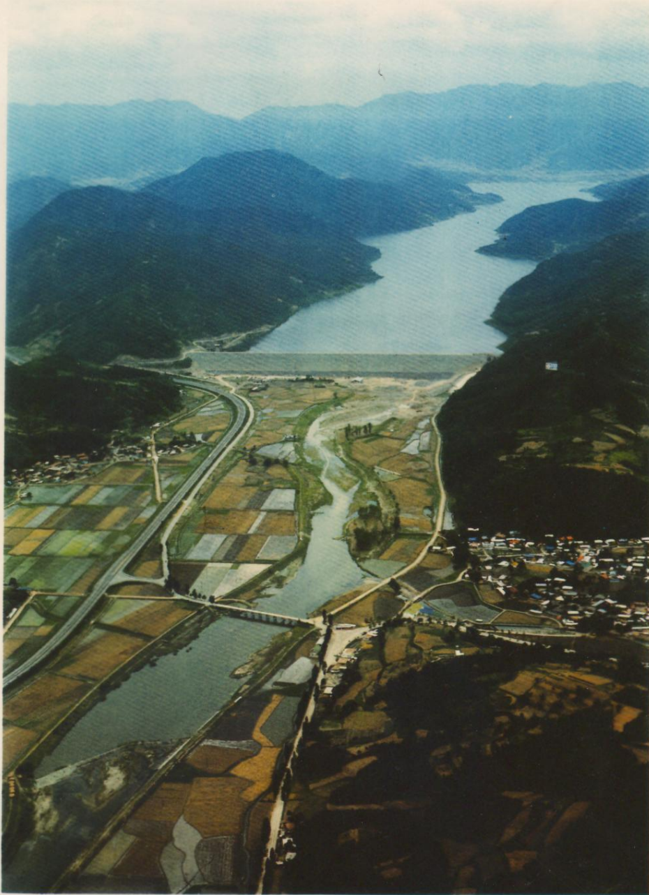
그림24 장성 농업용 댐(영산강) Changseong Irrigation Dam(Yeongsan R.)
