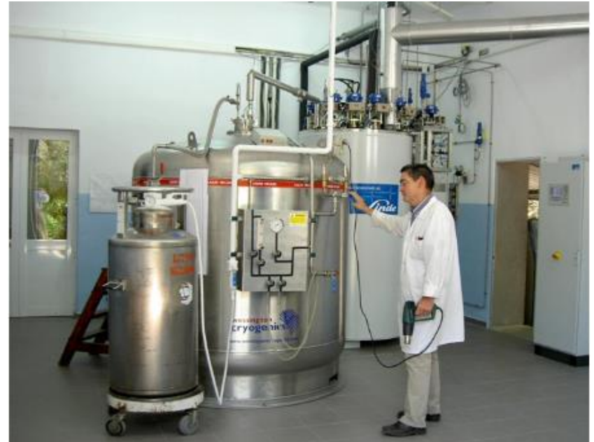
Linde L70 He liquefier (Portugal)
