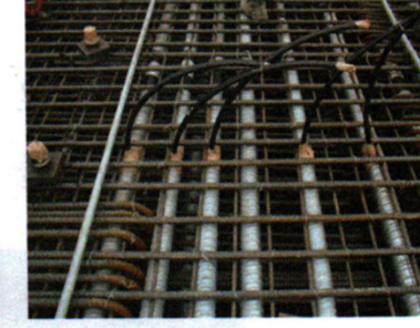
(h) Air Vent 설치
