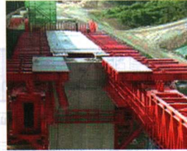
③ 박스 거더/세로 빔 설치
