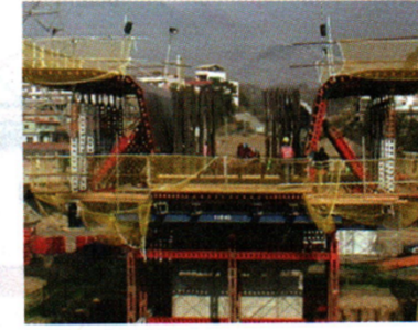
(d) 측면 거푸집 설치
