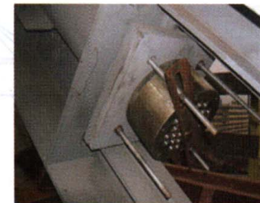
(d) DECK 앵커정착구 설치
