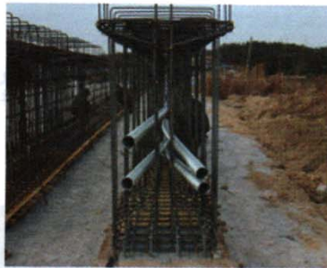
(b) 철근, 쉬스 조립
