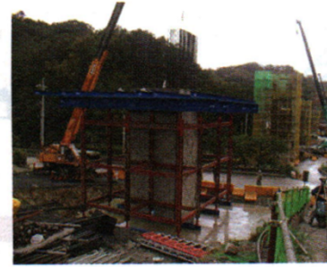
(c) 동바리/받침보 설치
