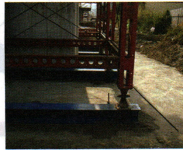
(b) 동바리 설치
