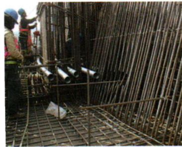
(e) 측면부 철근 쉬스관 설치
