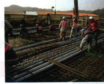
(g) 슬래브 철근/쉬스 설치
