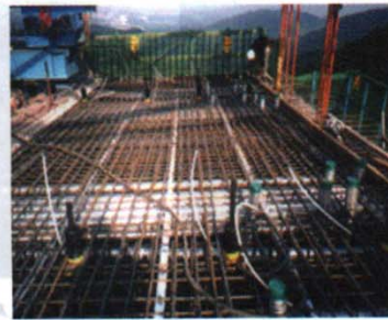
③ 세그먼트 철근 조립
