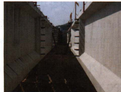
(c) Cross beam 설치
