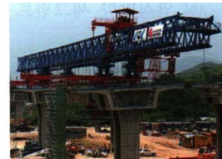
Movable Working Girder (매달아서 운반/가설)
