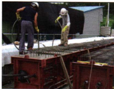
(d) 콘크리트 타설
