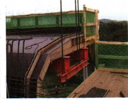
(d) 외측 거푸집 설치
