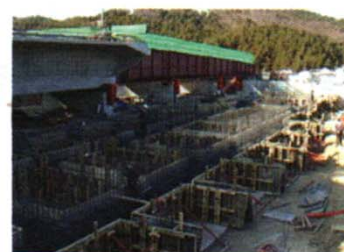
(c) 제작장 거푸집 설치
