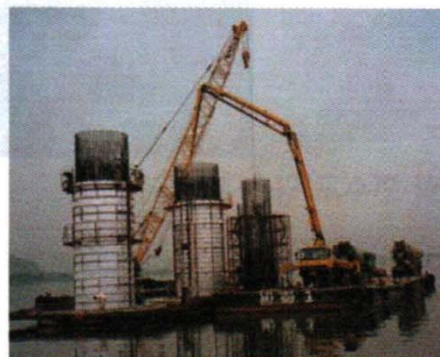
(b) 교각 콘크리트
