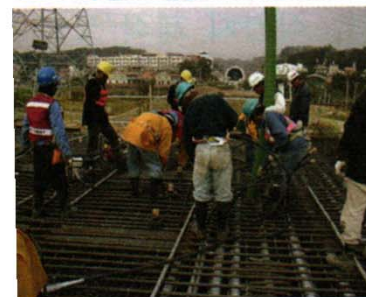
(i) 슬래브 콘크리트 타설
