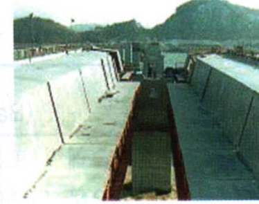
④ MSS 거푸집 설치
