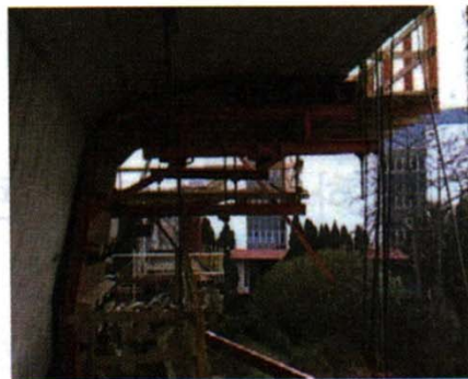
(e) 외측 거푸집 설치
