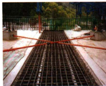
⑨ 키 세그먼트 철근 조립
