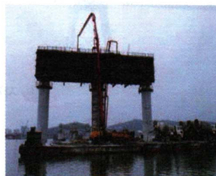
(c) 코핑부 콘크리트
