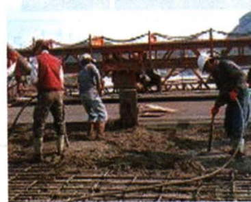
⑨ 상부 콘크리트 타설
