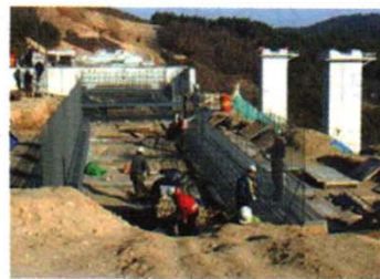
(b) 제작장 철근 조립
