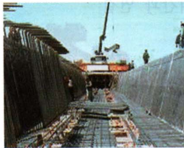
⑤ 하부 철근 조립
