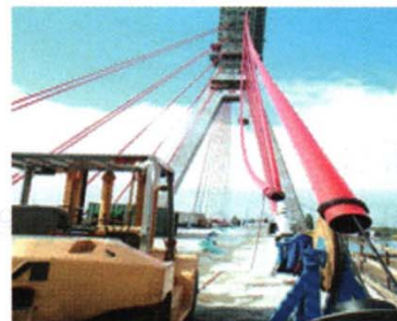
(g) HDPE PIPE 설치
