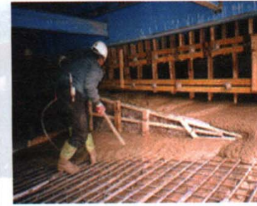
④ 콘크리트 타설
