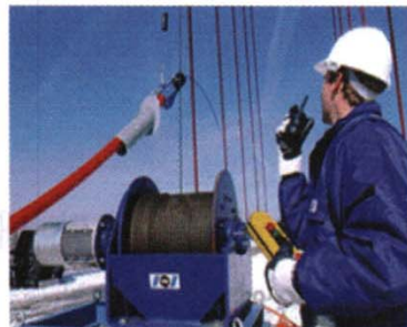
(f) HDPE PIPE 인양
