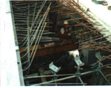
⑧ 키 세그먼트 수평버팀 설치
