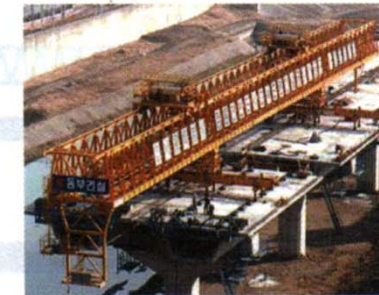
PSM 시공 전경
