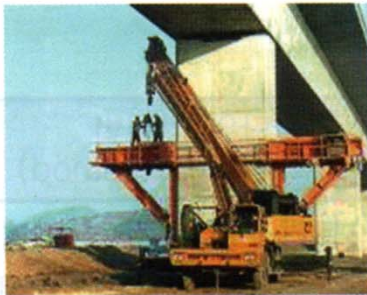
① 교각 브래킷 설치
