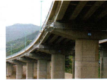
(i) IPC 교량 시공 완료
