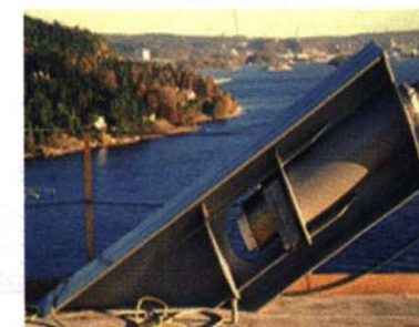
(l) 설치 완료된 케이블 정착부
