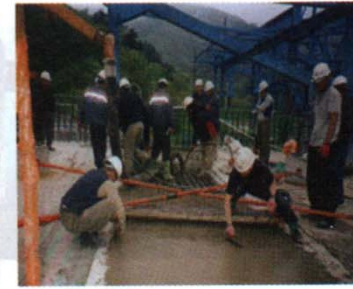
⑪ 키 세그먼트 콘크리트 타설
