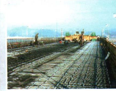
⑧ 상부 철근 조립
