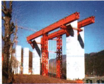
② 가벤트 설치
