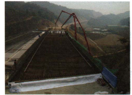
(b) 슬래브 콘크리트 타설
