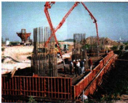
(a) 기초 콘크리트
