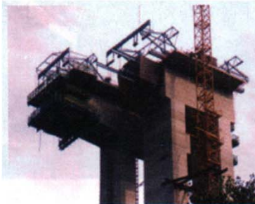
① 이동식 거푸집 설치
