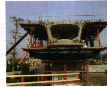
(k) 주두부 설치
