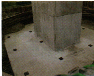
(a) Footing 상면 고르기
