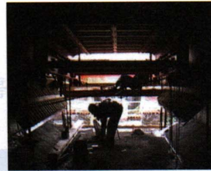
(f) 내부 거푸집 설치
