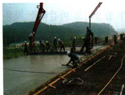
(g) 슬래브 Conc' 타설
