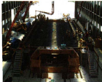
④ 콘크리트 타설
