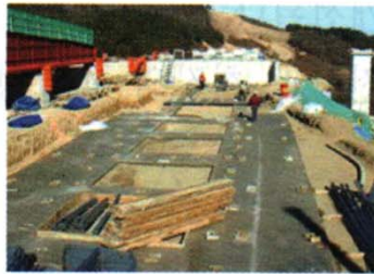
(a) 기초 콘크리트 타설
