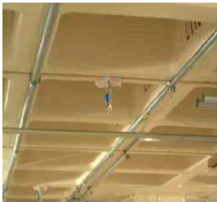
추락 방지 안전고리 거치대 설치
