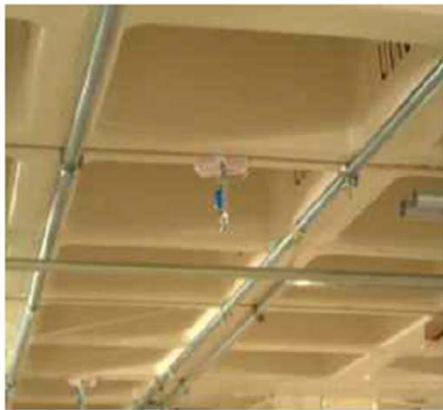
추락 방지 안전고리 거치대 설치
