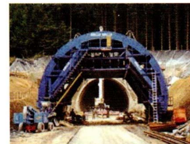
(b) 터널 외부 조립
