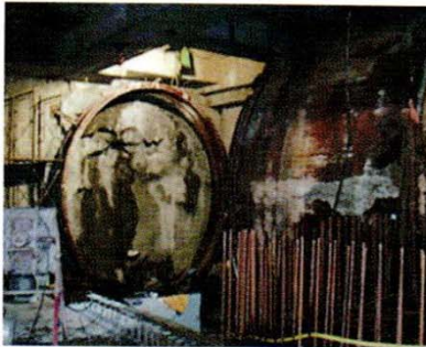
⑤ 엔트런스 팩킹 설치
