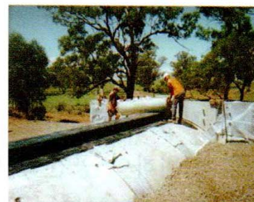
(g) Crown beam 거치/ 방수처리
