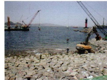
(f) 침매함체 주변의 되메우기
