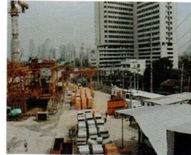
③ 후방시설 조립
