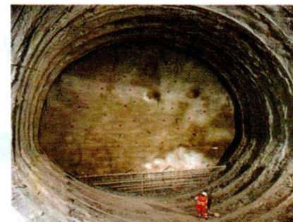
(b) 인버트 굴착 후 strut 설치
