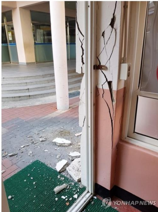
초등학교 지진 피해 (포항=연합뉴스) 15일 발생한 지진으로 경북 포항 한 초등학교 건물 기둥과 벽 일부가 금이 가거나 부서졌다. 2017.11.15 [독자 제공=연합뉴스]
