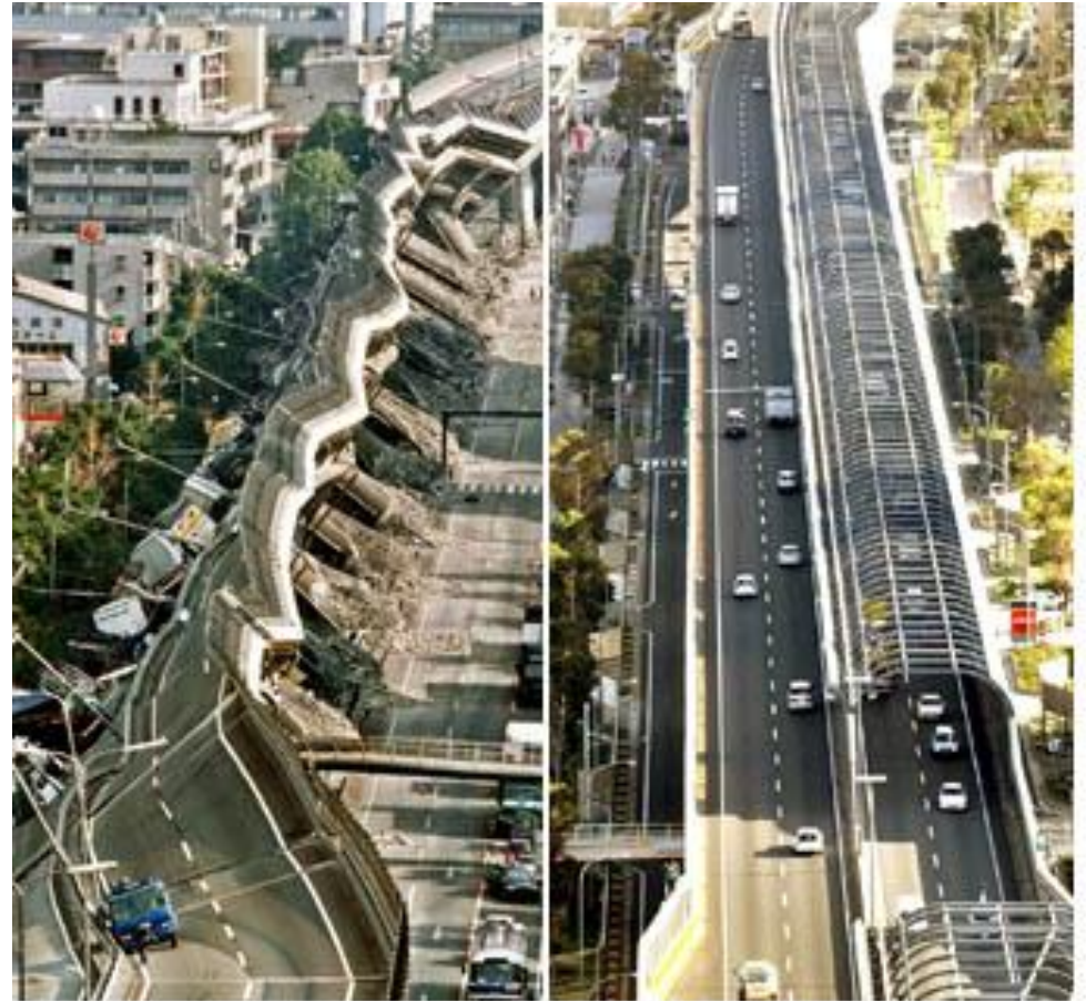
10년전인 1995년 1월 17일 엇가락처럼 휘어진 한신고속도로 (왼쪽)가 새로운 내진 공법으로 1년 8개월여의 공사끝에 말끔히 복구돼 차량들이 오가고 있다. /일본 산케이신문제공
