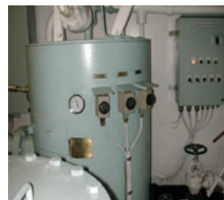
Hot Water Calorifier (온수기)
