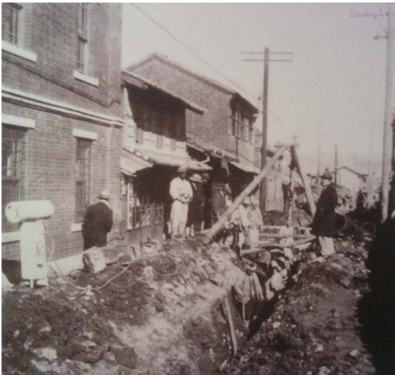
상수도관 부설 공사 (부산, 1930년대)
