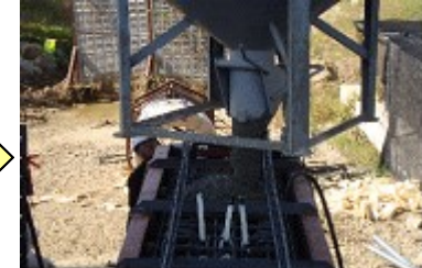
콘크리트 타설: 1일
