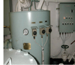
Hot Water Calorifier (온수기)
