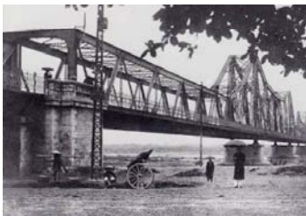
롱비엔 다리 (Long Bien Bridge, 1902)
