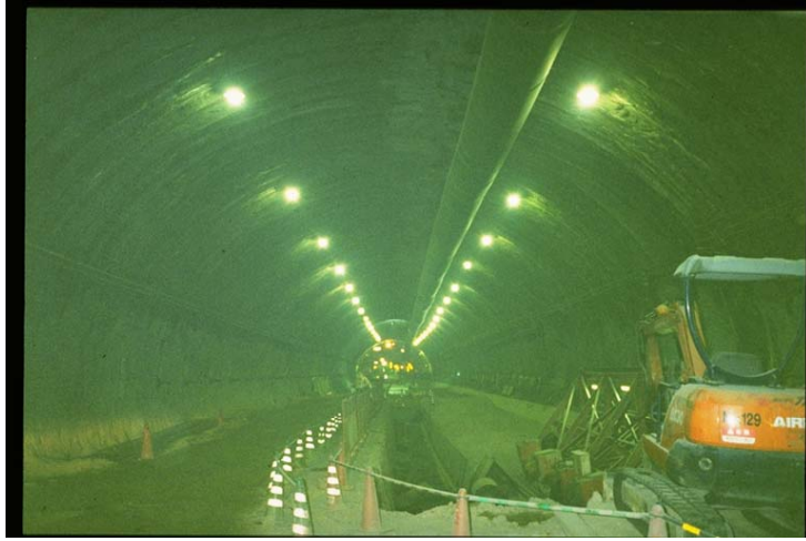
4층건물 지하 15m에서 시공중인 마이코 터널
