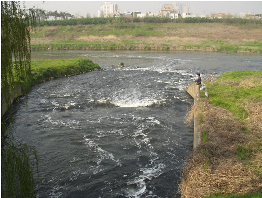
Effluent discharge channel (Tancheon STP)
