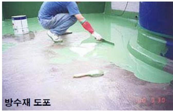
고무 휠라를 이용한 균일한 두께로 도포
