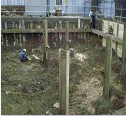
1. 포스트 파일 설치
