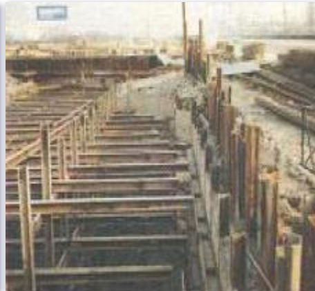
7. 띠장 및 버팀보 설치
