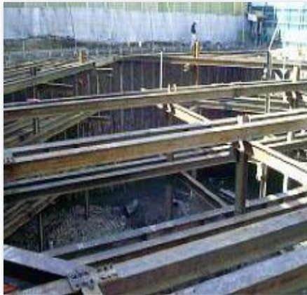
5. Main strut 설치
