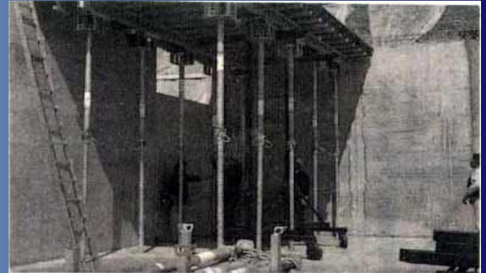
접이식 폼의 설치
